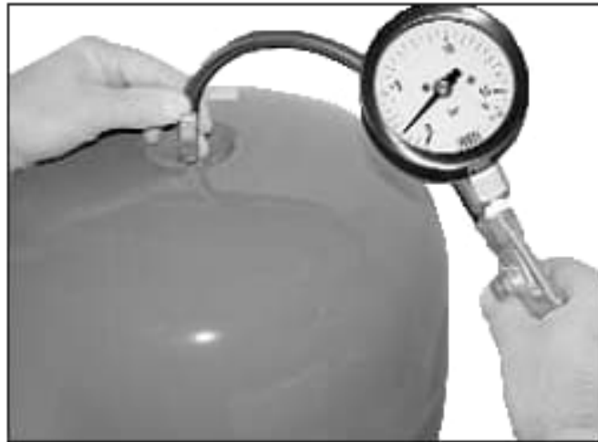
Рисунок 1 – Пример проверки давления
